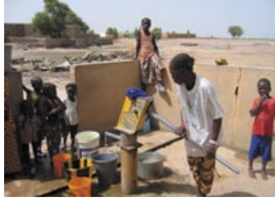
Borebrønn med pumpe
